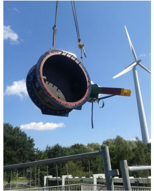
Schöpfwerk Wasserhorst: Ausbau einer Pumpen-Rückschlagklappe für Wartungsarbeiten
