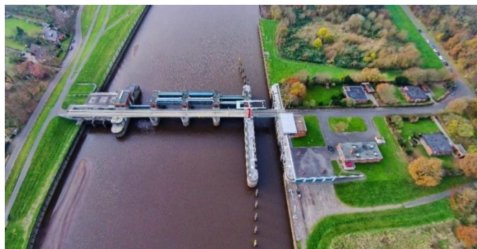
Lesumsperrwerk. Foto: Reymond Hoins
