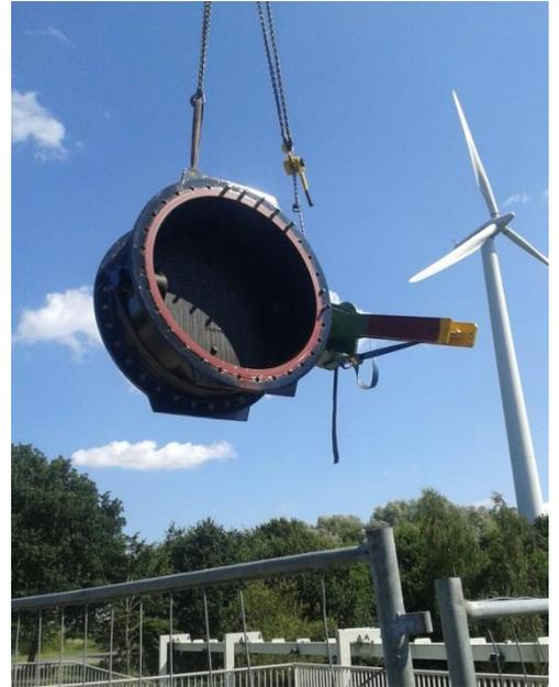
Schöpfwerk Wasserhorst: Ausbau einer Pumpen-Rückschlagklappe für Wartungsarbeiten
