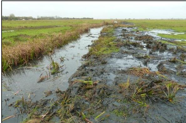
Abb. 17 Aushub wird dicht am Fleet angelegt
