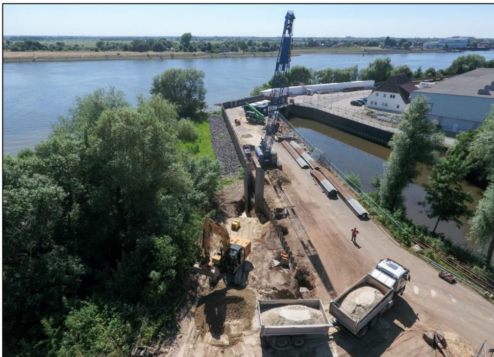
Herstellung einer Hochwasserschutzwand am Einlauf der Blumenthaler Aue in die Weser
