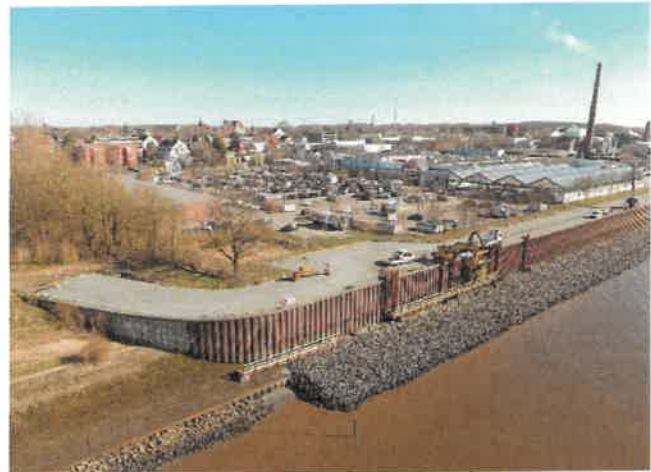
Ehemaliges BWK-Gelände Stabilisierungsarbeiten an der alten Spundwand durch Deckwerk und Verankerungen
