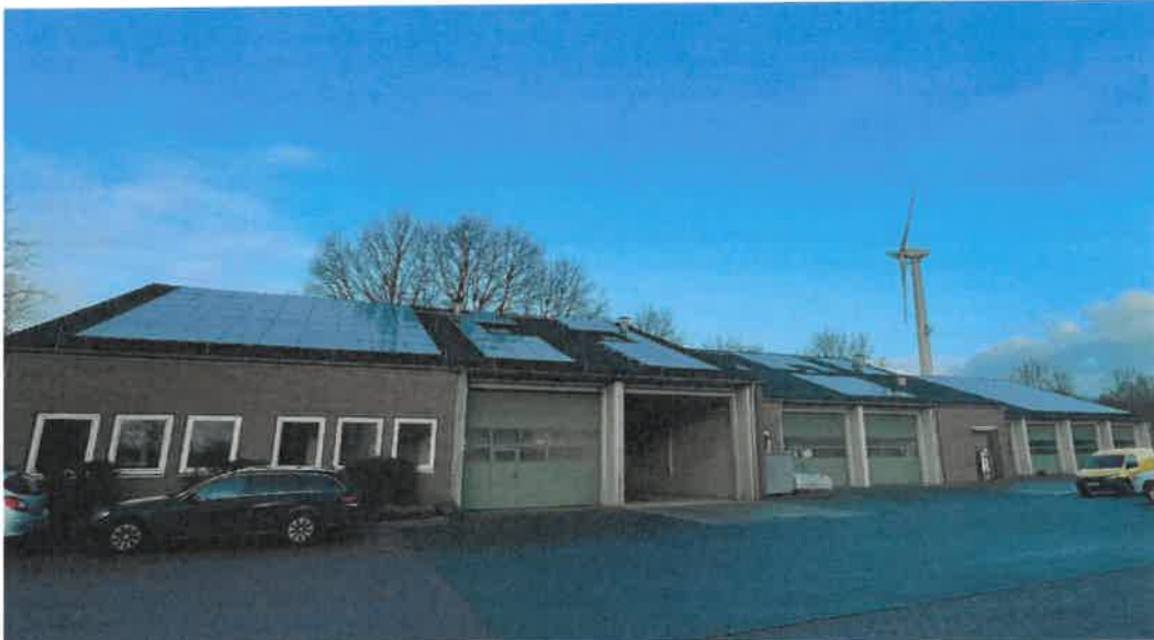
Die Windenergieanlage und die Photovoltaikanlage am Betriebshof
