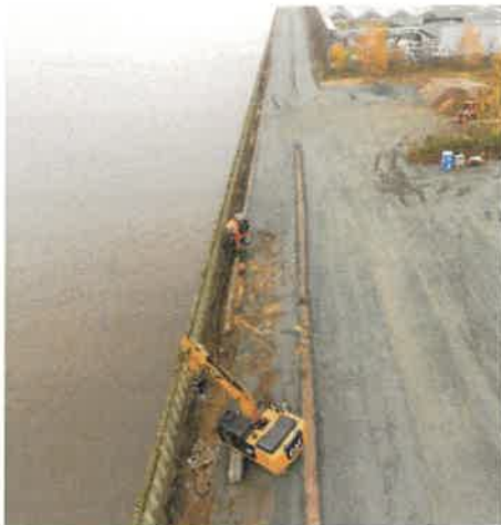
Ehemaliges BWK-Gelände Stabilisierungsarbeiten an der alten Spundwand durch Deckwerk und Verankerungen
