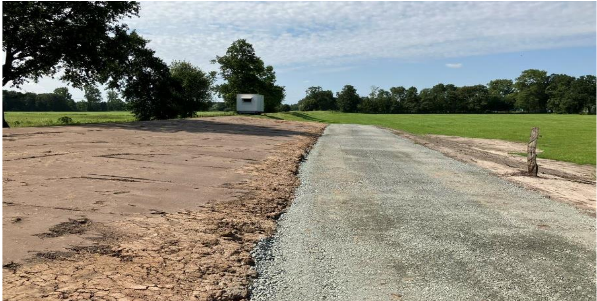
Neubau Deichverteidigungsweg in Warf-Butendiek
