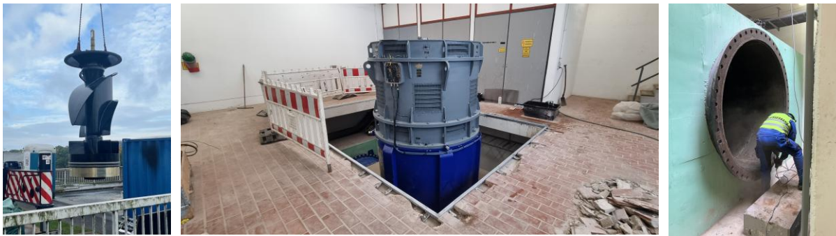
Arbeiten am Lesumsperrwerk: Wiedereinbau der vertikalen Propellerpumpe III.
