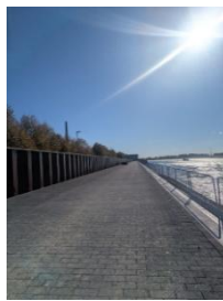
Fertig gepflasterte Promenade
